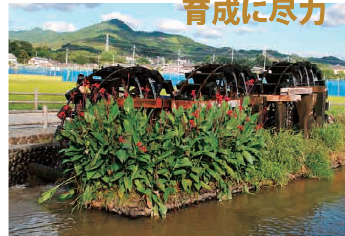
筑後川の水をくみ上げる三連水車
